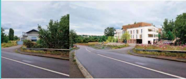
VUE DEPUIS LA RUE MARCELLIN BERTHELOT AVANT DÉMOLITION ET APRÈS
